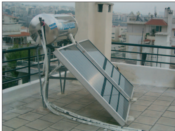
Εικ. 7.4 Τα δύο είδη θερμοσιφώνων: α) ηλεκτρικός, β) ηλιακός
